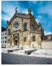
ResMüAHK.I, Fassade, DE001178, BSV
